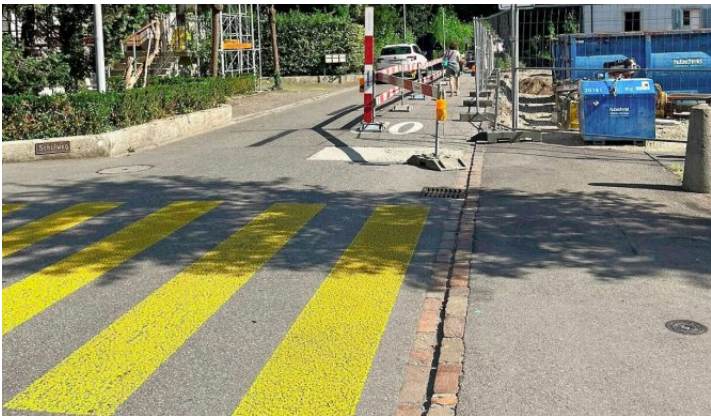
Nun ist für die Fussgänger ein sicherer Bereich entlang der Baustelle an der Rigistrasse ausgewiesen. Bild: zvg
