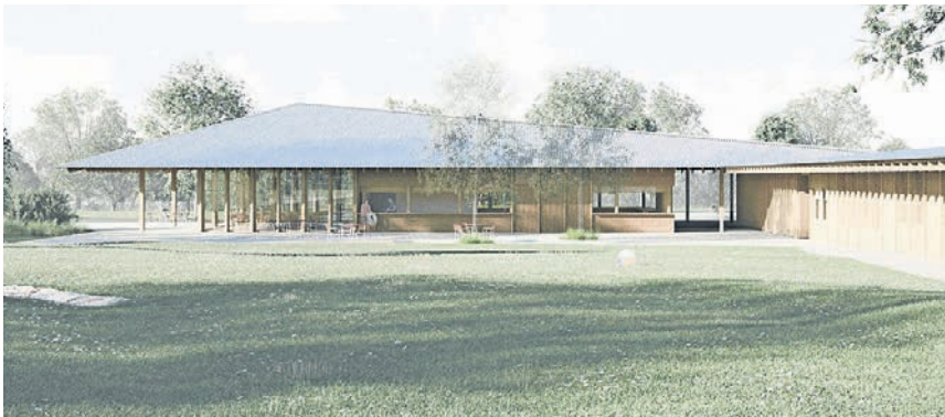
Blick auf den Gastroteil (links) des winkelförmigen Neubauprojekts am künftigen Zugang zur Badi Muri.
